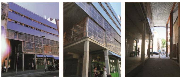
Figura 3. Edificio de cooperativa de viviendas La Borda, en Barcelona. PH: Luciana Pellegrino.
