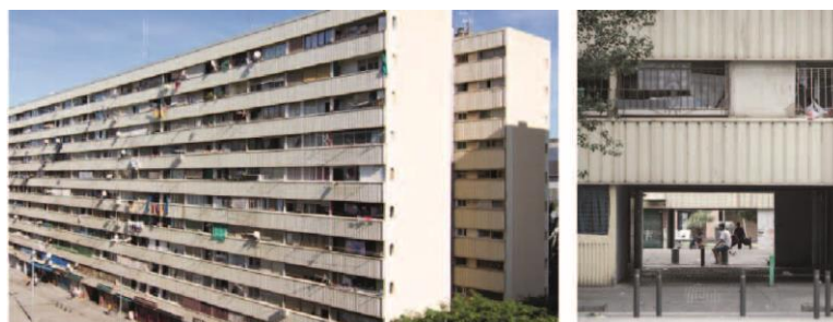
Figura 4. Edificios de viviendas en el barrio de La Mina, en Sant Adrià del Besós, Barcelona.
